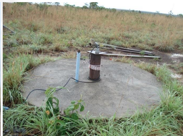
Foto 02. Poço tubular
