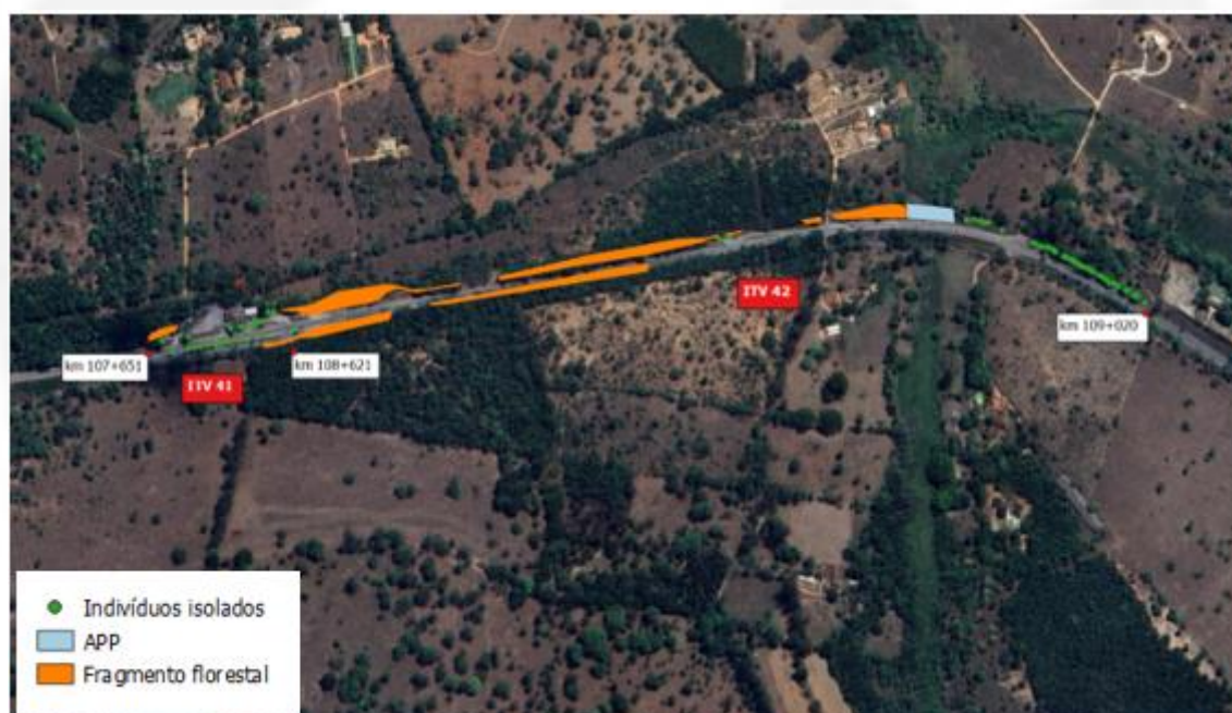
Figura 3-11 Intervenções ao longo das ITVs 41/42
