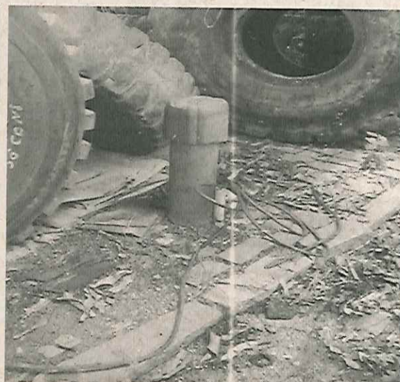
Foto 16: Poço tubular desativado.
