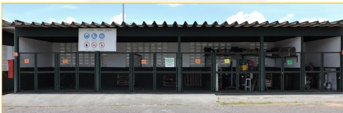
Figura 05: Central de resíduos sólidos - baias de armazenamento temporário de resíduos classes I e II
