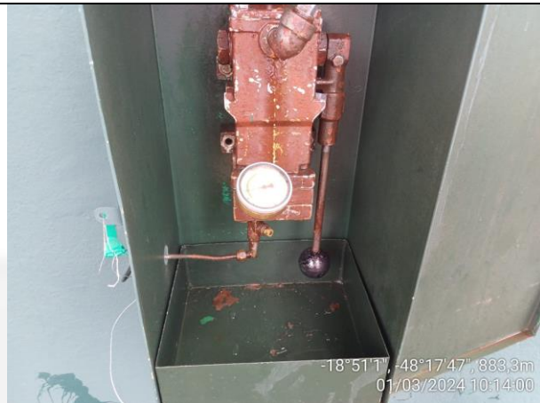
Foto 12: Macaco hidráulico e "cassinha" com mini bacia de contenção
