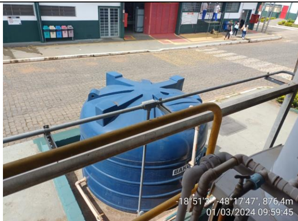
Foto 05: Tanque de acumulação de efluentes tratados (ETEI)
