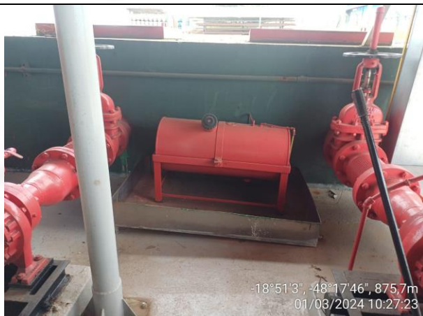
Foto 20: Reservatório de gasolina sobre bacia de contenção
