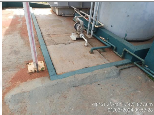
Foto 02: Caixa de sedimentação e acumulação (ETEI)
