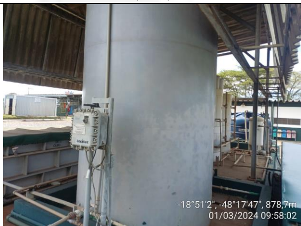
Foto 03: Tanque de acumulação de efluentes brutos (ETEI)
