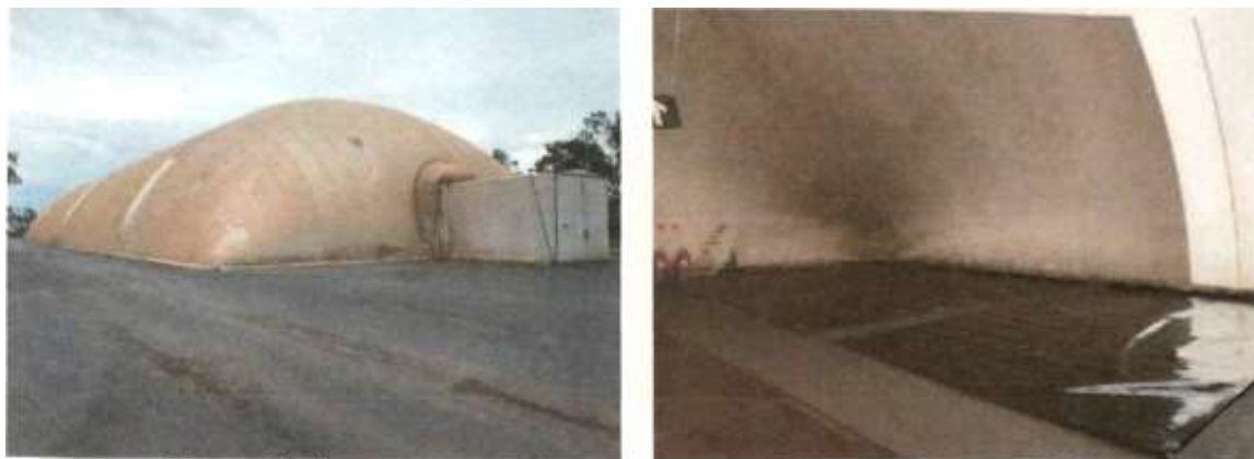
Figura 01: Imagem externa e interna da estufa de secagem solar em balão.
