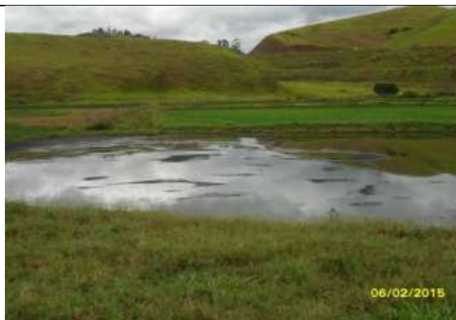
Figura 3: 3ª lagoa, sem impermeabilização.
