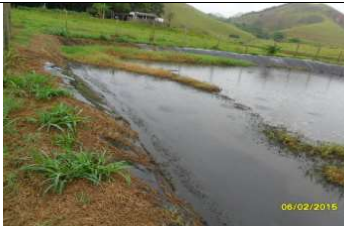
Figura 2: 2ª lagoa de tratamento - Impermeabilizada.
