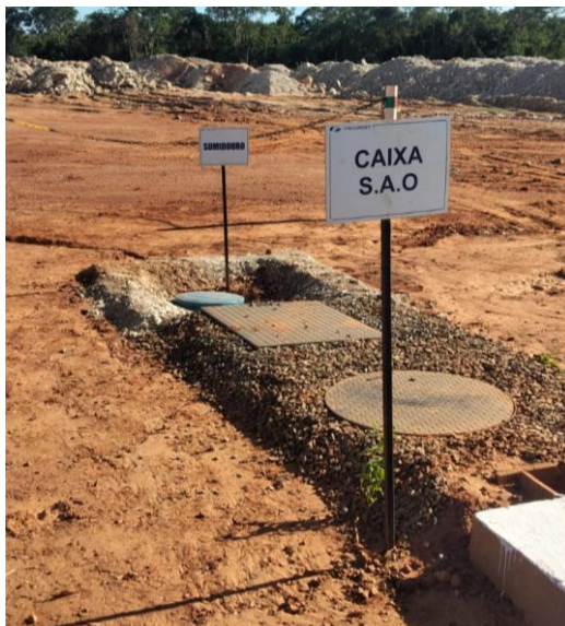
Figura 2-6 Caixa SAO e sumidouro
