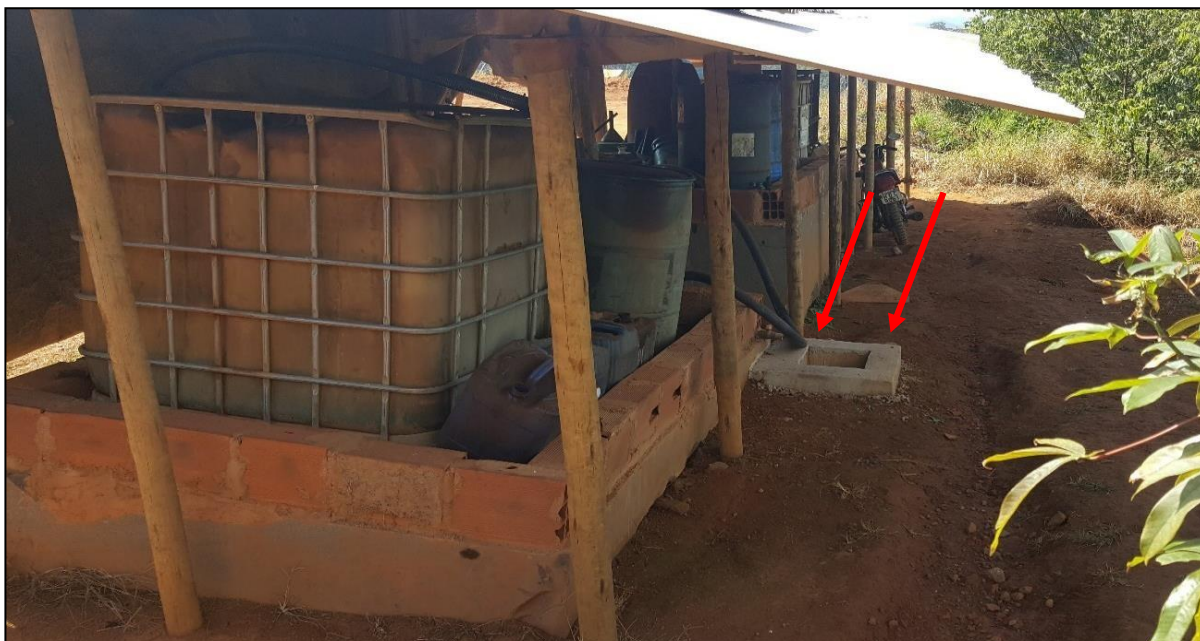
Imagem 6: Bacia de acondicionamento de resíduos e produtos, página 13 do Relatório Fotográfico apresentado
