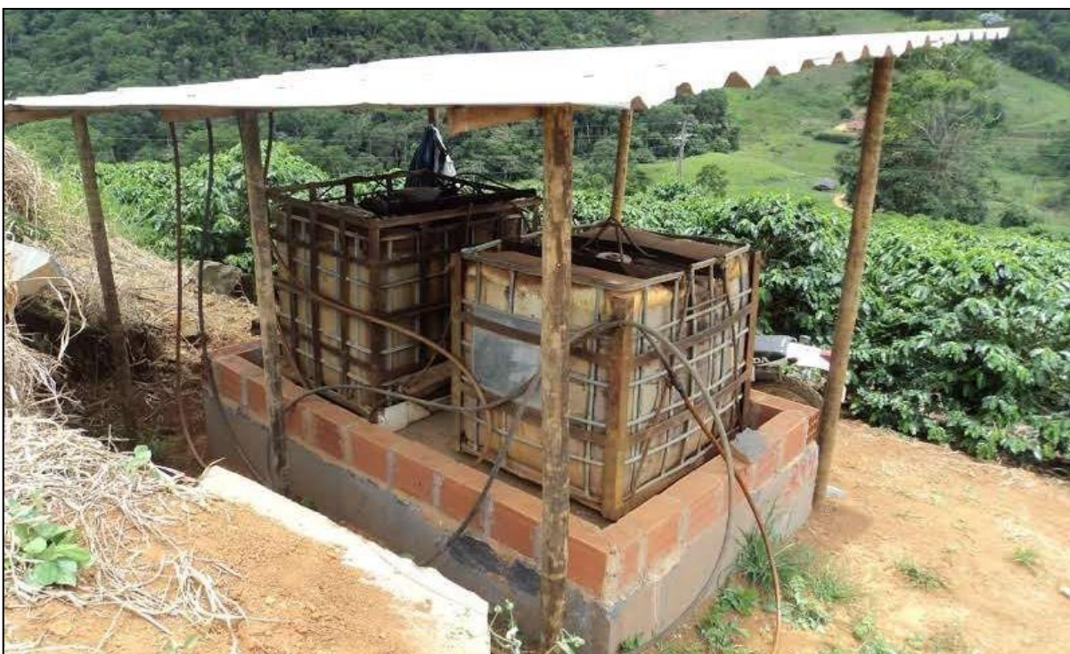
Imagem 5: Bacia de acondicionamento de resíduos e produtos, página 12 do Relatório Fotográfico apresentado
