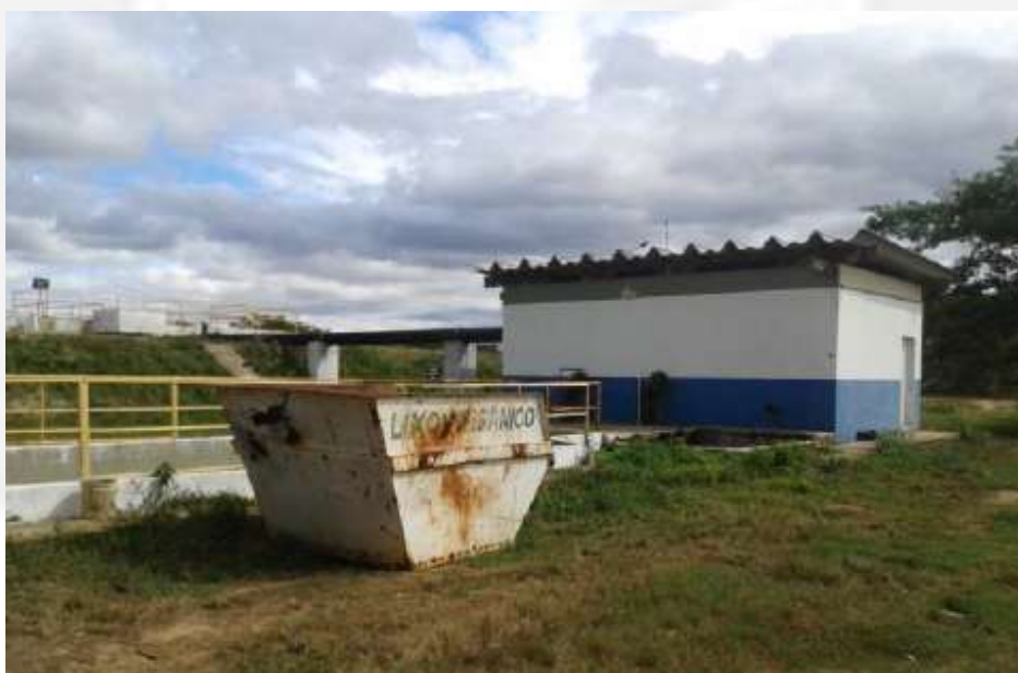
Imagem 9.2: Caçamba estacionária ao lado do tratamento preliminar para armazenamento temporário dos resíduos de limpeza.
