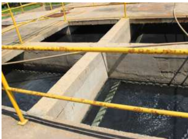
Figura 7: Reatores anaeróbios da ETE.
