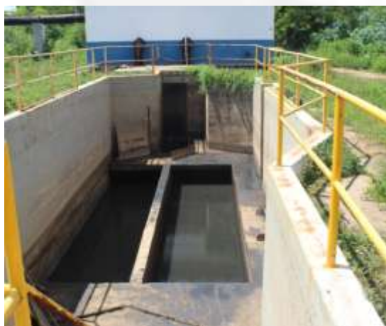
Figura 5: Caixas de areia do tratamento preliminar.
