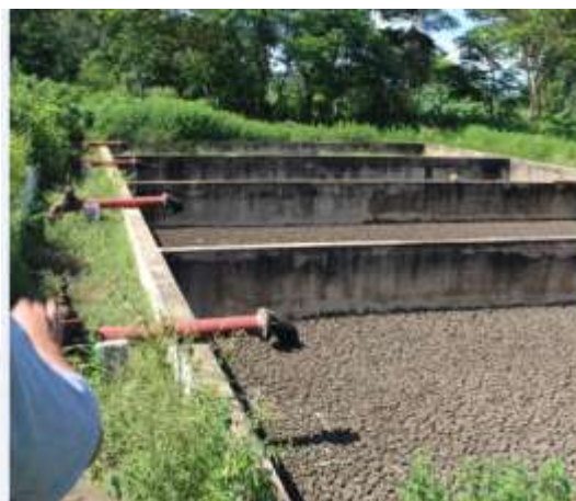
Figura 8: Leitos de secagem da ETE.
