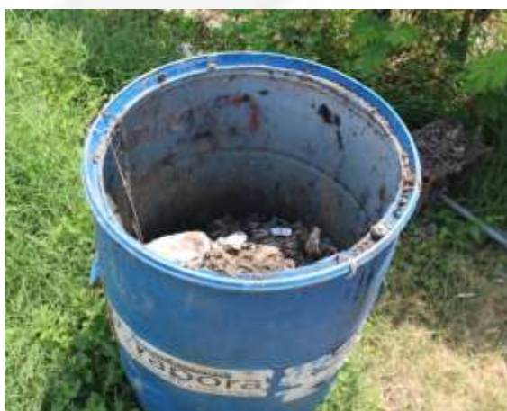
Figura 3: Recipiente para armazenamento temporário dos resíduos do gradeamento da estação elevatória 1.
