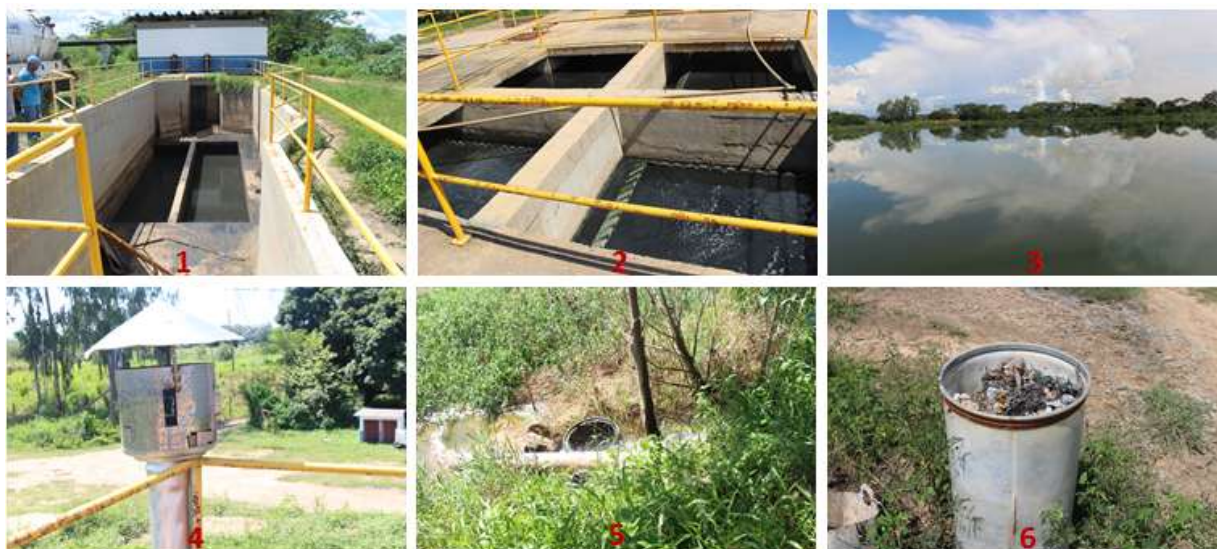
Imagem 2.2: (1) Tratamento preliminar; (2) Reatores anaeróbios; (3) Lagoa Facultativa; (4) Queimador de gás; (5) Ponto de lançamento de efluente tratado no rio São Francisco e; (6) Recipiente de armazenamento de resíduos recolhidos no gradeamento.
