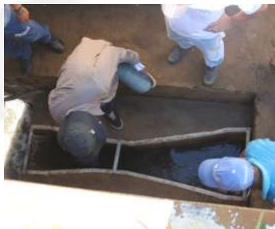
Figura 6: Calha Parshall da ETE.
