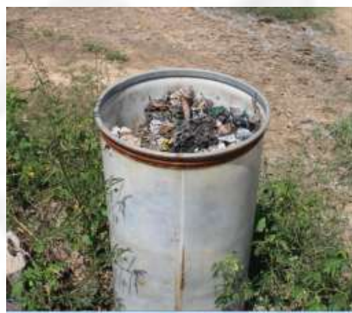
Figura 4: Recipiente para armazenamento temporário dos resíduos do gradeamento da ETE.
