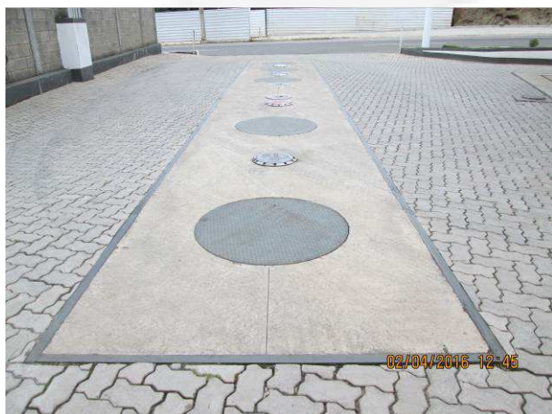
Foto 13 – Área de descarga pista superior com piso impermeabilizado e canaleta que direciona possíveis vazamentos para caixa SAO.
