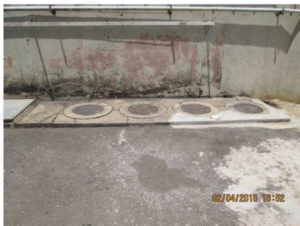
Foto 8 – Caixa SAO, destinada ao tratamento dos efluentes advindos do lavador de veículos.
