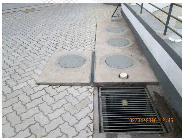
Foto 4 – Caixa SAO que atende a Pista de abastecimento superior.
