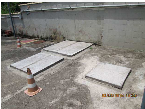
Foto 7 – Fossa séptica atende a pista inferior.
