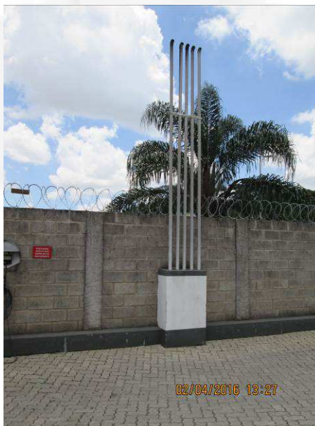
Tubulação com respiros instalada no posto visão.
