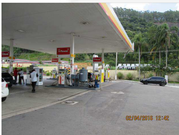
Foto 1 – Caneletas seguem a projeção da cobertura da pista de abastecimento.
