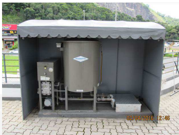
Foto 12 – Filtro de diesel com SUMP.
