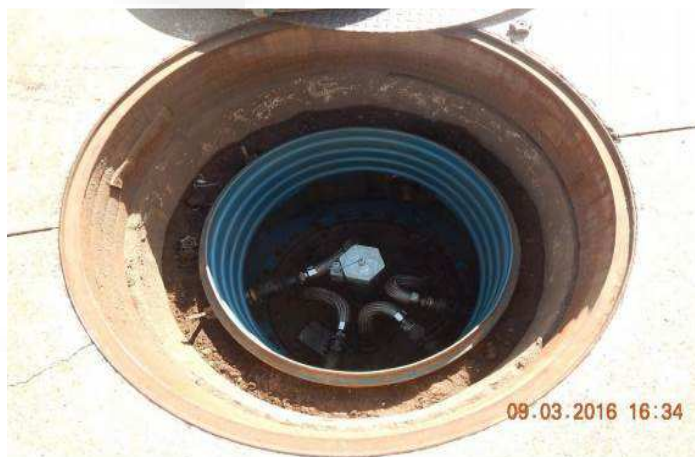
Foto 14 – Sistema de controle intersticial, instalado na boca de visitas.
