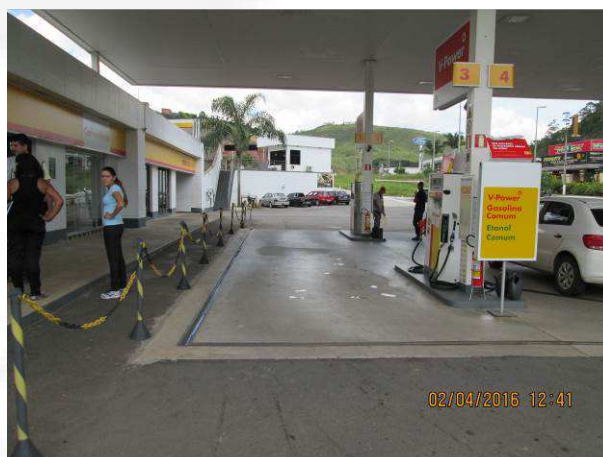
Foto 2 – Pista de abastecimento inferior com caída em direção as caneletas.
