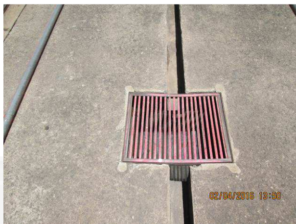
Foto 6 – Caixa de retenção separação de sólidos, atende ao lavador de veículos.
