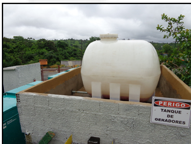
Figura 9: Tanque óleo diesel dos geradores.
