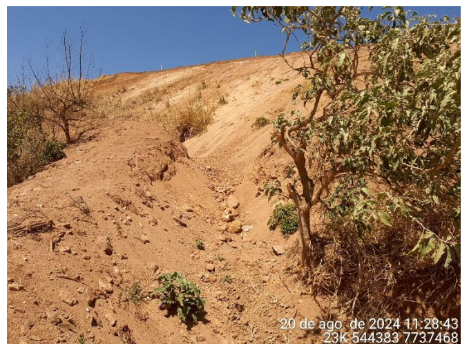
Foto 76: Canal de direcionamento de água e sedimento proveniente da pilha de estéril.
