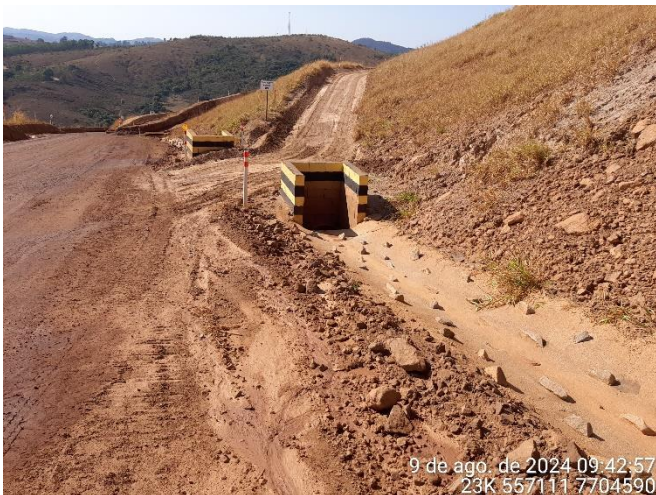
Foto 63: Canaleta concretada ao longo do acesso à área operacional.
