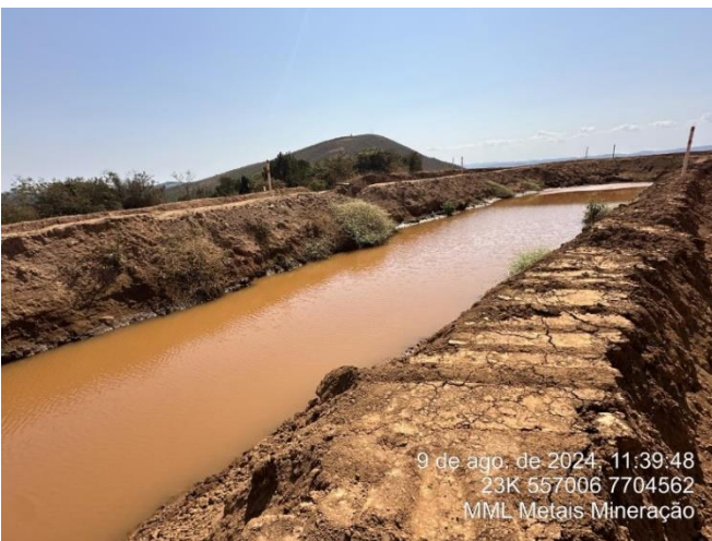
Foto 39: Tanque de acumulação de água pluvial, e efluentes advindos das CSAO.
