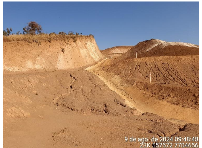
Foto 64: Canaleta próxima aos sumps 05 e 06.
