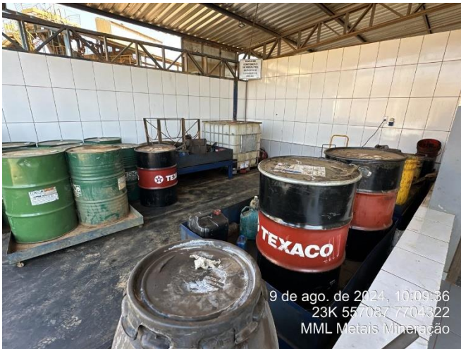
Foto 31: Armazenamento de resíduos Classe I e óleo usado – Oficina industrial.
