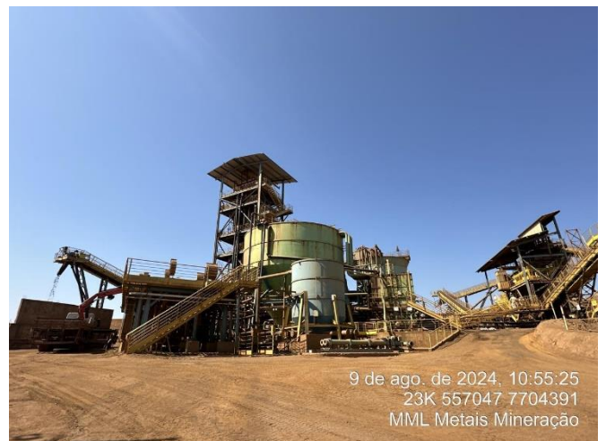
Foto 4: Vista da parte de trás da UTM, onde é possível observar os tanques de espessamento da lama.
