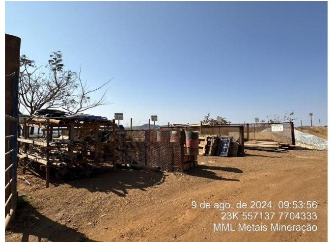
Foto 60: Materiais dispostos em baias, segregados por tipologia.
