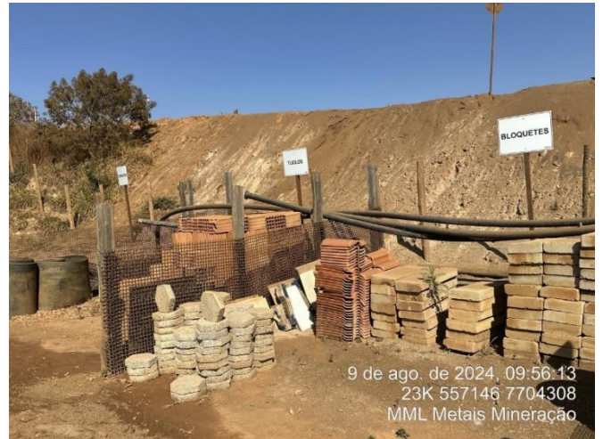
Foto 62: Bloquetes a serem utilizados nas pavimentações, dispostos no pátio de obras.
