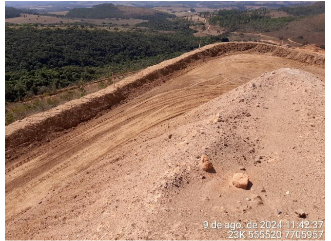
Foto 66: Leira circundando bermas na pilha de estéril na região da cava 97.
