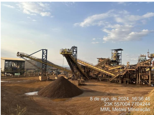
Foto 3: Vista frontal da UTM.
