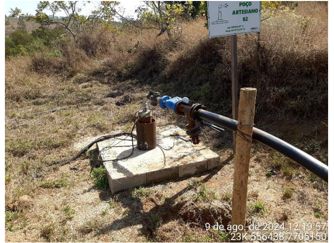
Foto 84: Poço 02 com área impermeabilizada de concreto.
