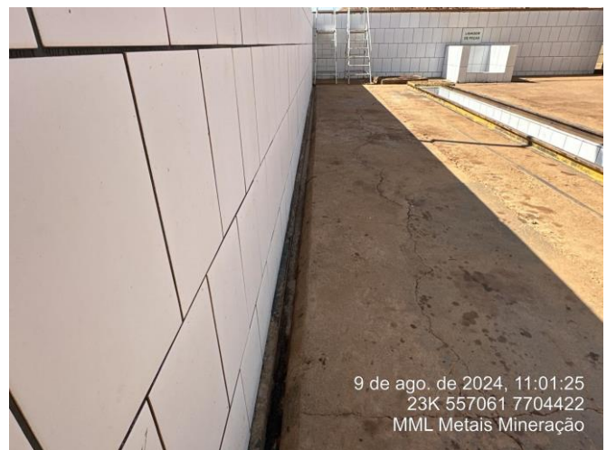
Foto 52: Detalhe das canaletas circundando a área do lavador de veículos.
