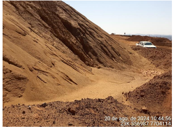
Foto 18: Talude com elevada inclinação coberto com material arenoso. Essas condições caracterizam fatores impeditivos à implantação do PRAD nesses taludes.
