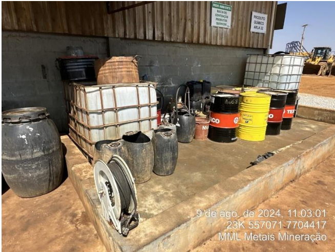
Foto 29: Local de armazenamento dos resíduos Classe I – Oficina mecânica.
