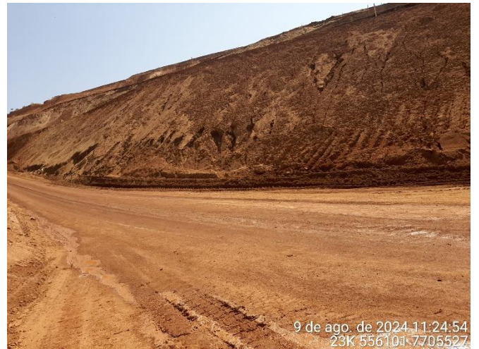
Foto 20: Talude na pilha da cava 9, com erosões em diversos pontos.
