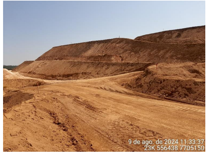
Foto 12: Taludes e bermas implantados na área da cava 97.
