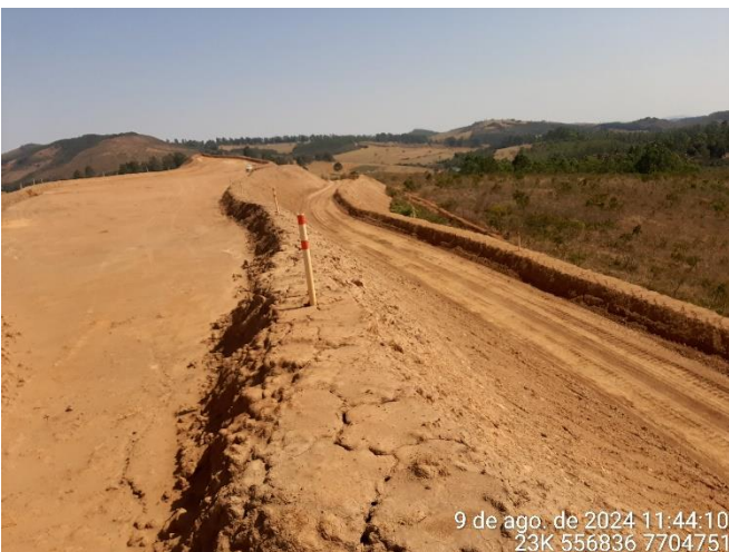
Foto 21: Leiras ao longo da bancada da pilha de estéril com rachaduras. Conformação com material argiloso.
