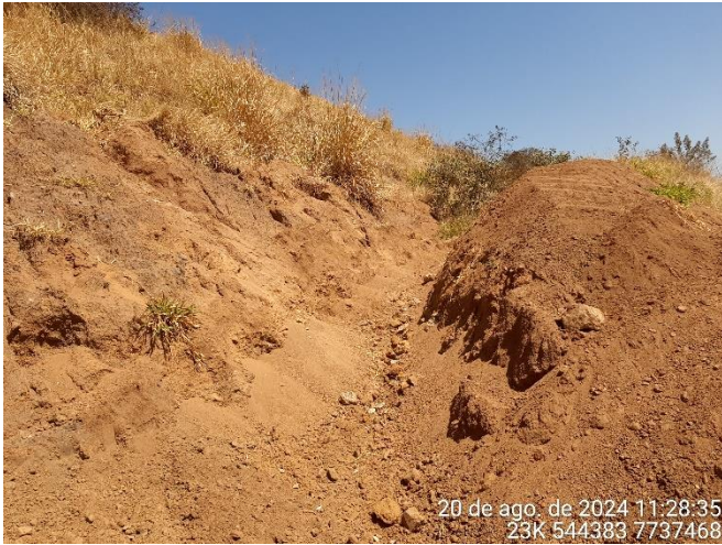
Foto 77: Outra porção do canal de direcionamento de água e sedimento proveniente da pilha de estéril.-
