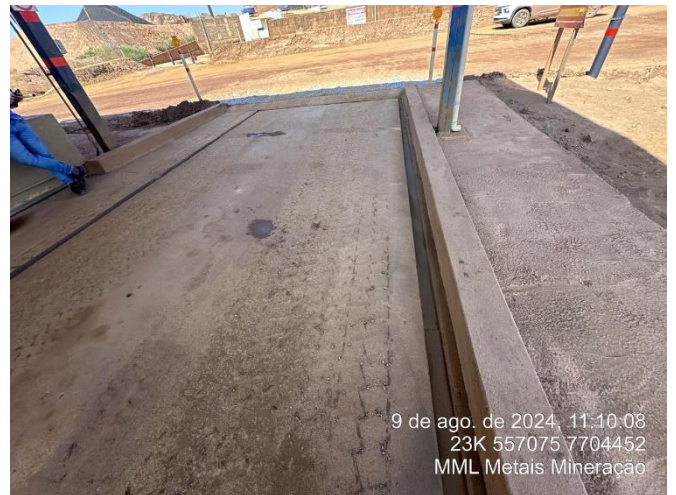
Foto 56: Pista de abastecimento com canaleta a circundando.
