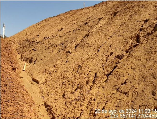
Foto 17: Talude com estéril arenoso com formação de diversos processos erosivos.
