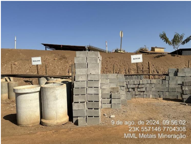
Foto 61: Materiais para obra civil acondicionados, como tijolos e manilhas.
