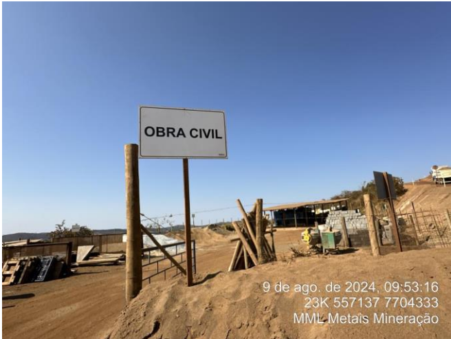
Foto 59: Entrada do pátio de obra civil.
