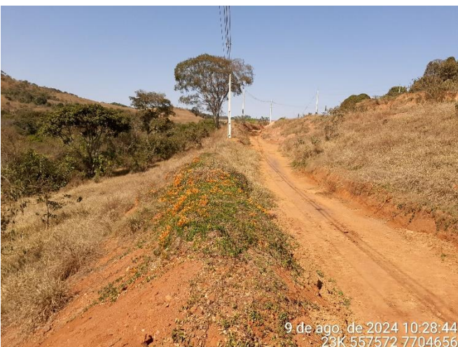
Foto 99: Linha de transmissão elétrica, acesso e área com cobertura vegetal exótica existente dentro do limite estabelecido para a reserva legal da matrícula 12.344.
