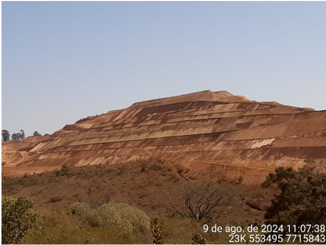
Foto 11: Pilhas de estéril conformadas em parte da cava 97.
