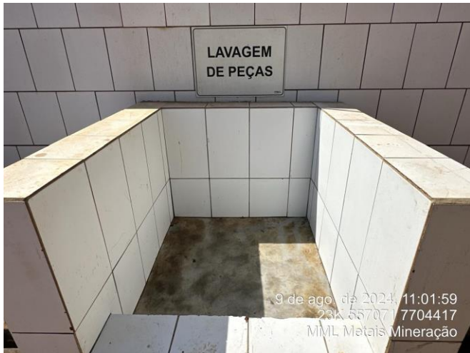
Foto 53: Área destinada a lavagem de peças.
