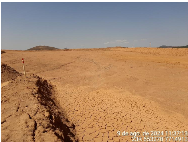
Foto 15: Bancada superior da pilha de estéril localizada próxima a cava 97.
