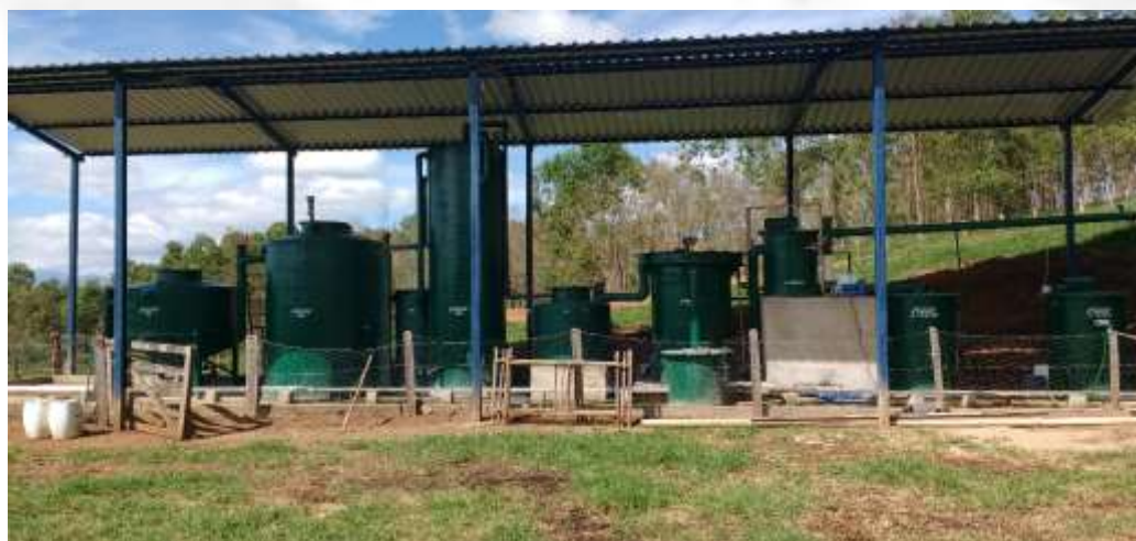
Foto 03. Estação de Tratamento de Efluente Líquidos - ETE
