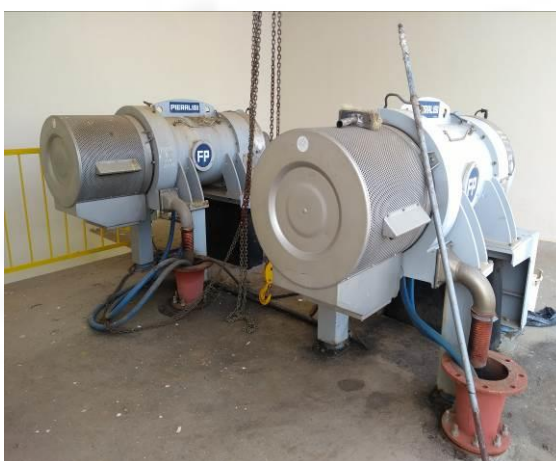
Foto 08. Centrífuga de lodo
