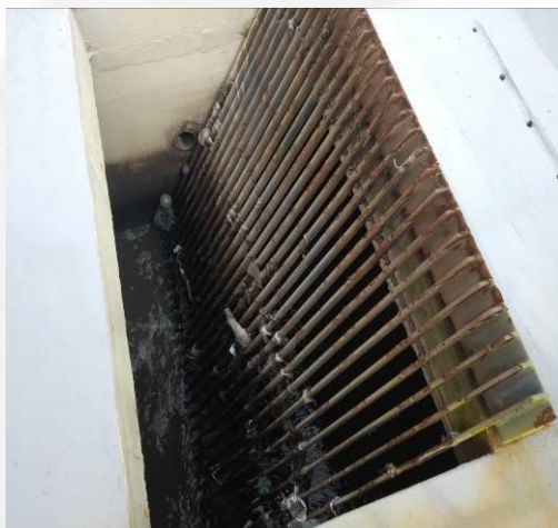
Foto 03. Desarenador aerado.
