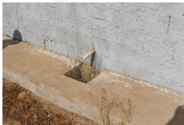
Foto 02. Detalhe do cano que pode direcionar vazamentos de óleo para o exterior do galpão.
