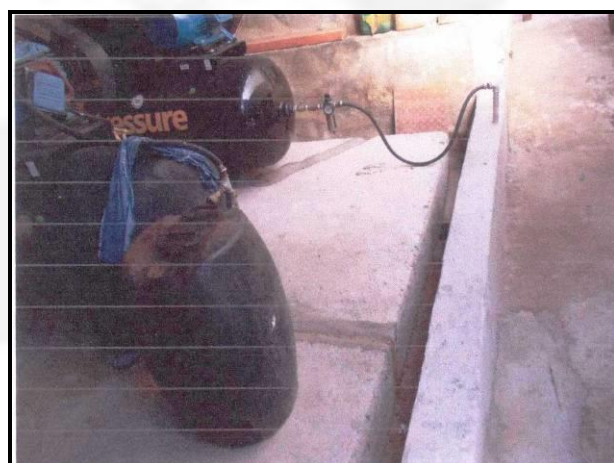
FOTO 04 – Área dos compressores com canaletas de drenagem interligadas a ETEI
