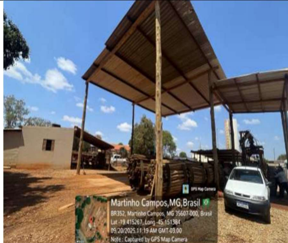
Foto 01. Área com Autoclave e tanque
