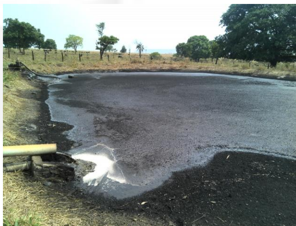
Figura 06. Lagoa de estabilização
