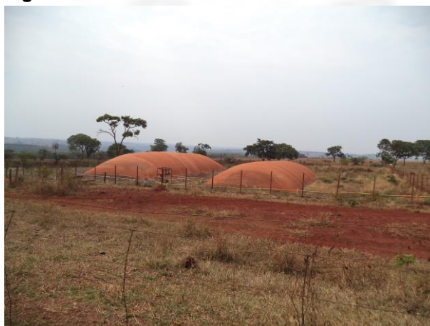
Figura 04. Vista dos biodigestores
