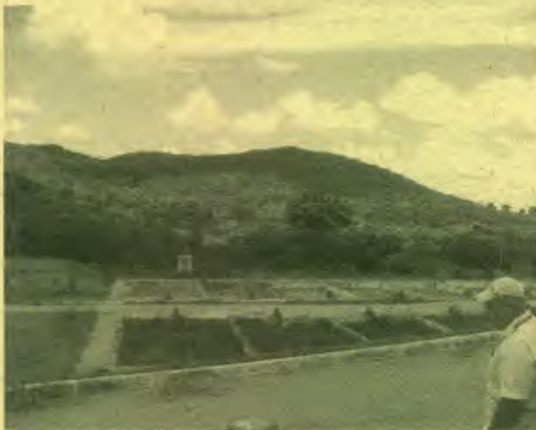
Foto 01. Leitos de secagem tomados por vegetação.
