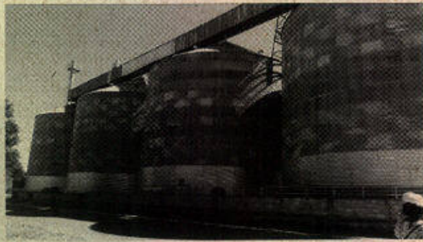
2. Silos de armazenamento
