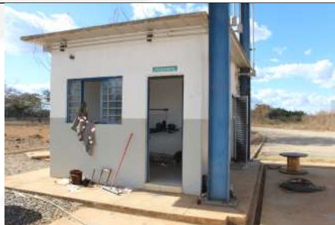
Foto 2: Sala de Comando
