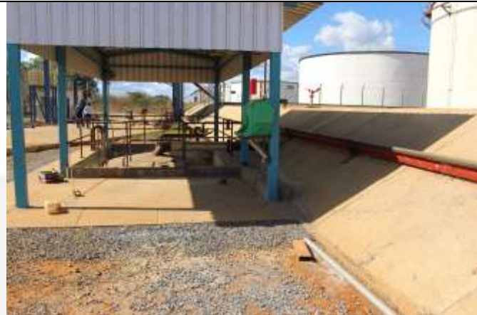
Foto 4: Tanque Pulmão e Dique Contenção
