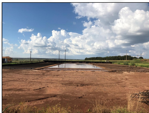
Figura 10: Tanques de sedimentação – águas residuárias
