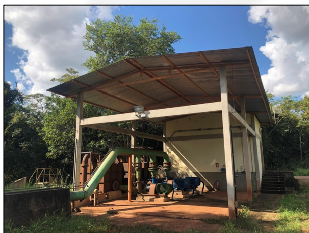
Figura 7: Casa de bombas - Captação de água superficial
