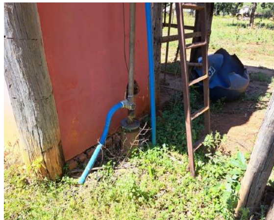
Figura 02: Poço tubular sem sistemas de medição e laje sanitária. Fonte: URA NM, 2023.
