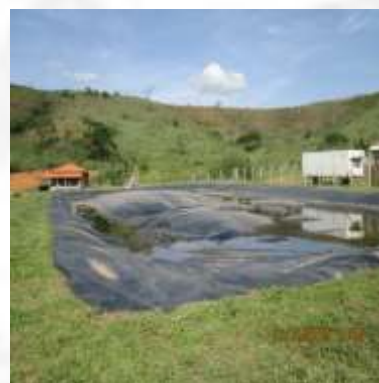
Figura 9: Lagoa de tratamento biológico anaeróbico.
