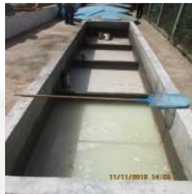
Figura 7: Sistema de remoção de gordura.
