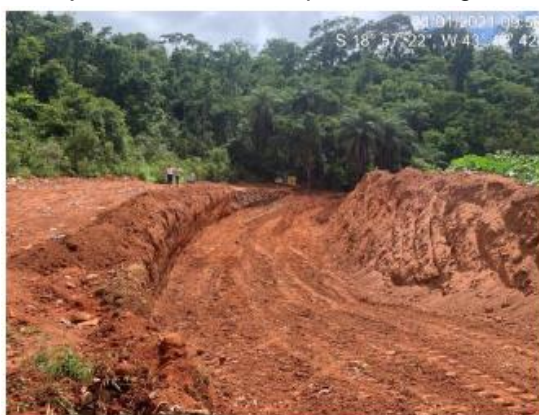
Figura 03: Nova vala com abertura iniciada
