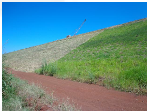
Figura 3 - Vista do dique da lagoa SEP II durante manutenção de vegetação
