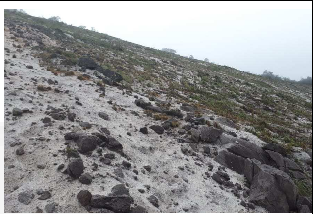
Foto 02 – Material/solo (areia) de superfície.
