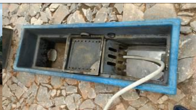
Figura 8 - Caixa de gradeamento da ETE
