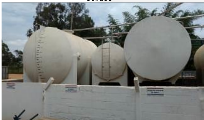
Figura 15 - Tanques de descarte de soro
