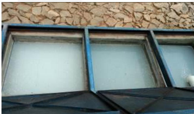
Figura 9 - Tanques de decantação
