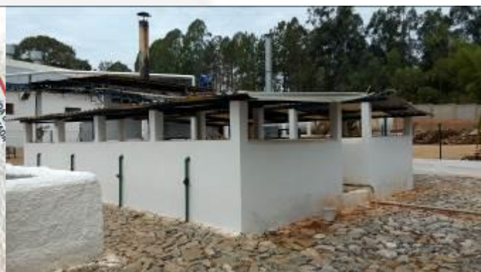
Figura 12 - Leitos de secagem do lodo da ETE
