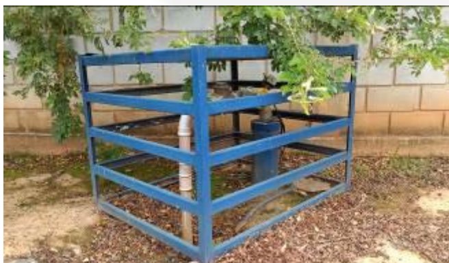
Figura 19 - Poço tubular dotado de hidrômetro e horímetro
