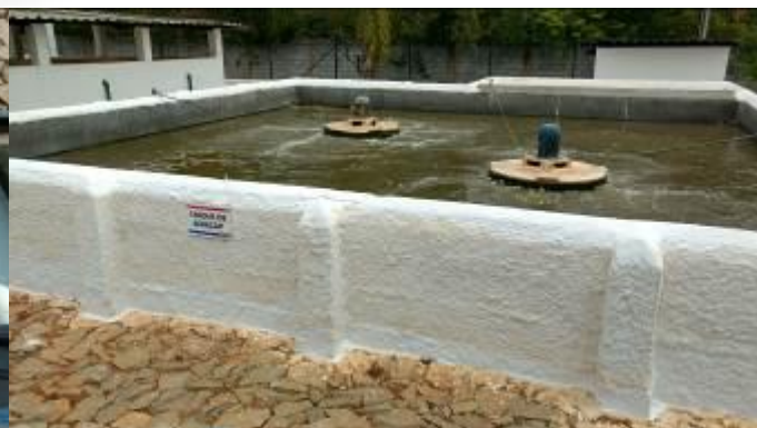
Figura 10 - Tanque de aerção
