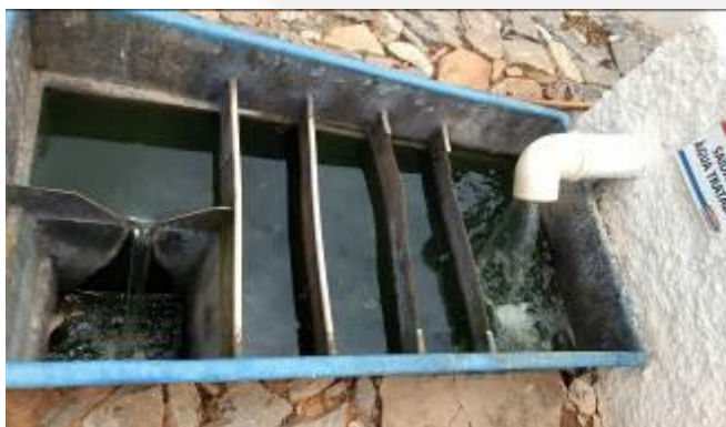
Figura 11 - Tanque de contato final
