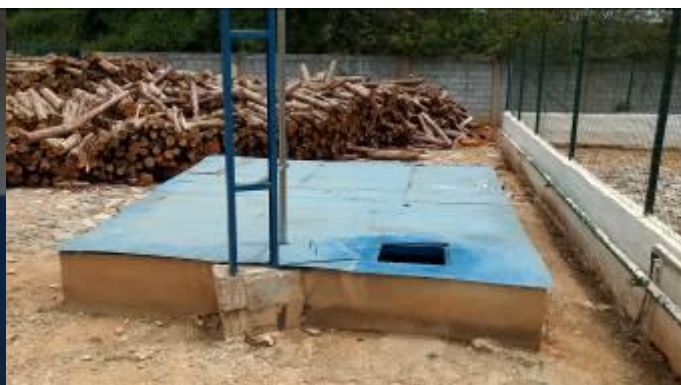
Figura 14 - Tanque subterrâneo de soro, com depósito de lenha ao fundo
