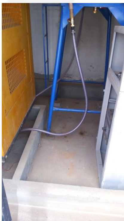
Foto 07. Contenção do tanque aéreo
