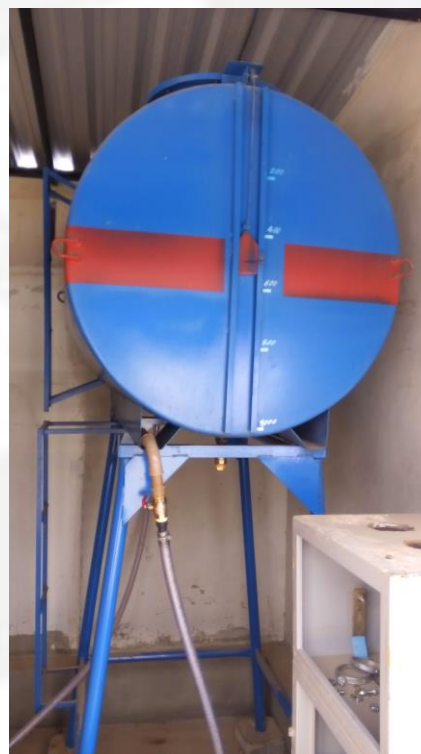
Foto 08. Tanque aéreo de óleo diesel.
