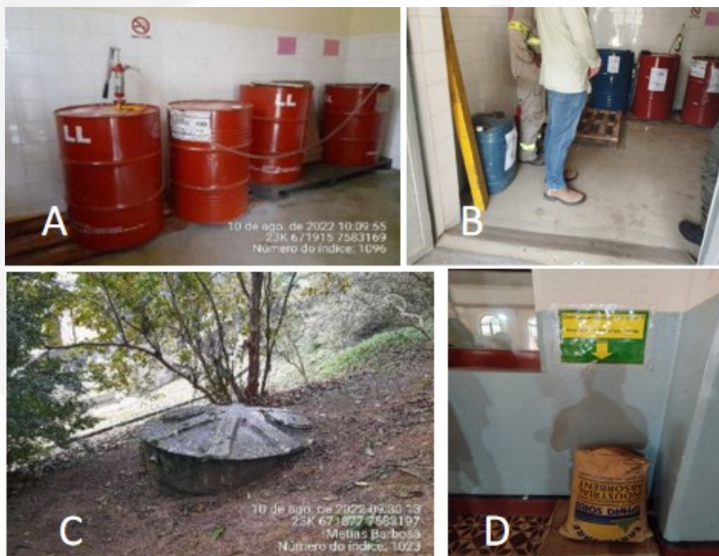
Figura 24 - Equipamentos de controle e prevenção de derramamento de óleo no empreendimento. A) Estoque de óleo armazenado em local abrigado provido de sistema de contenção (B), (C) Caixa SAO, (D) Kit para limpeza de óleo. Fonte: RCA, CLAM, 2022 e FEAM, 2024.
