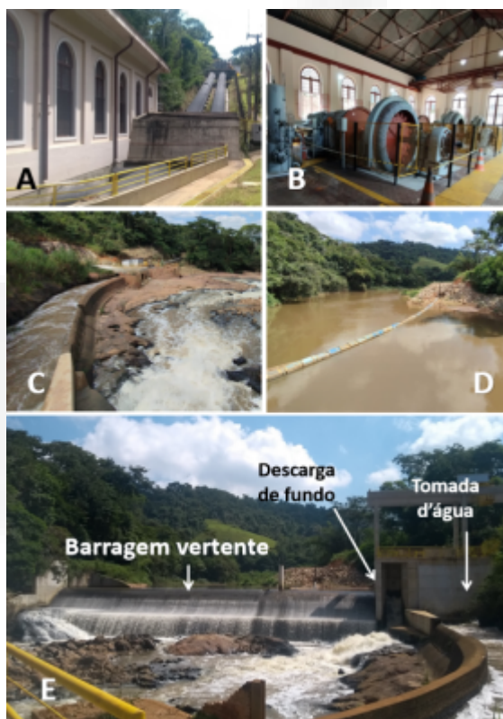
Figura 3 - Fotografias ilustrativas das estruturas civis da CGH Paciência: A) Casa de Força e conduto forçado; B) Conjunto gerador; C) Canal de adução; D) Reservatório; E) Barramento e comportas (tomada d'água e descarga de fundo). Fonte: FEAM, 2024.
