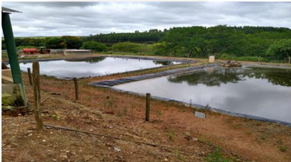
Lagoa de estabilização de efluentes agroindustriais
