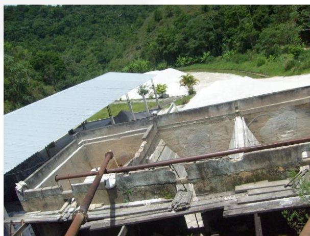
Foto 02. Vista de parte do sistema de beneficiamento da areia, caixas-silo e galpão de ensacamento à esquerda.
