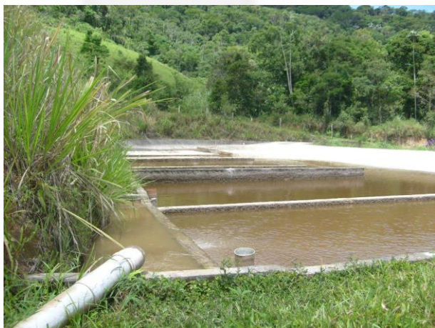
Foto 03. Parte do sistema de tratamento de efluentes industriais (caixas ou lagoas de decantação)
