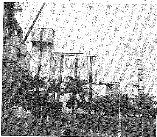
Foto 09. Condições de lançamento dos efluentes atmosféricos
