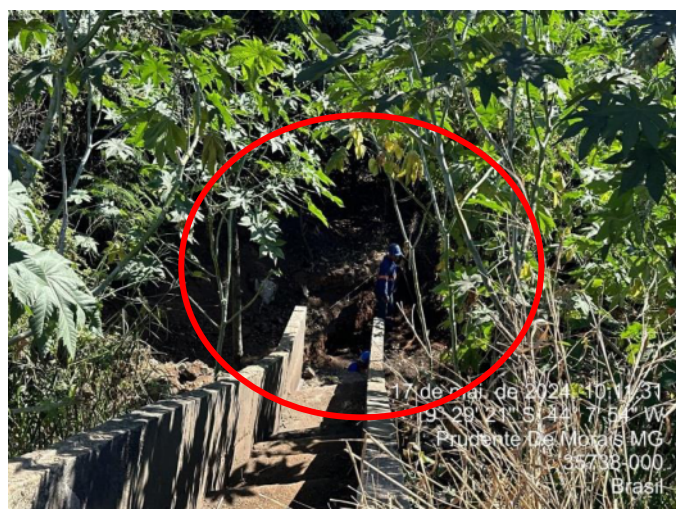
Foto 28: Implantação de uma terceira caixa de decantação, que irá incorporar o sistema de drenagem do empreendimento
