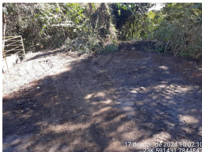
Foto 42: Materia empurrado para fora da área do projeto. Neste local foi observado indícios de carreamento de sedimentos pela água de chuva.
