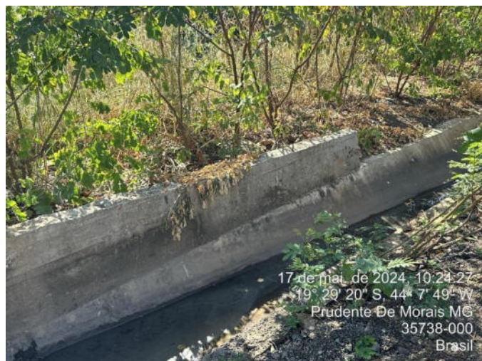
Foto 6: Canaleta de drenagem que precisou ser alteada
