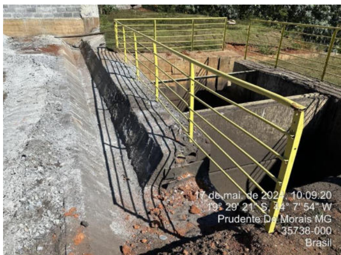
Foto 25: Caixa de decantação próxima a área de sinterização
