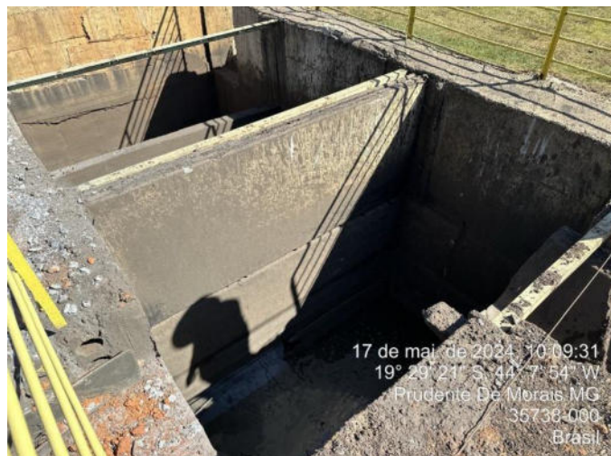
Foto 26: Caixa de decantação próxima a área de sinterização
