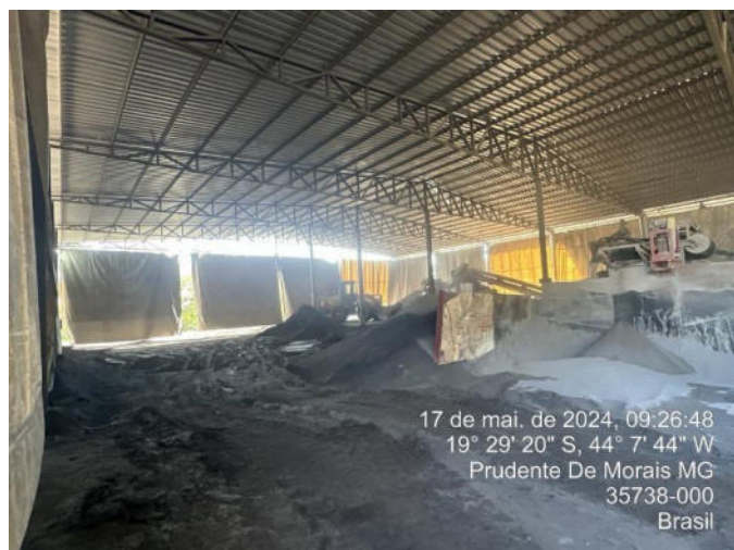
Foto 13: Área no galpão de triagem, com toldos plásticos objetivando enclausurar o galpão e minimizar a fuga de particulados
