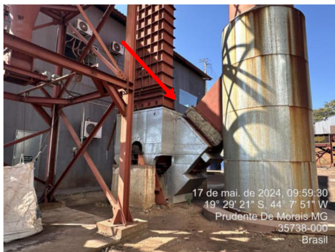
Foto 34: Abafador tipo "lã de rocha" instalado no filtro
