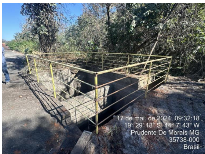
Foto 23: Caixa de decantação próxima ao galpão de triagem
