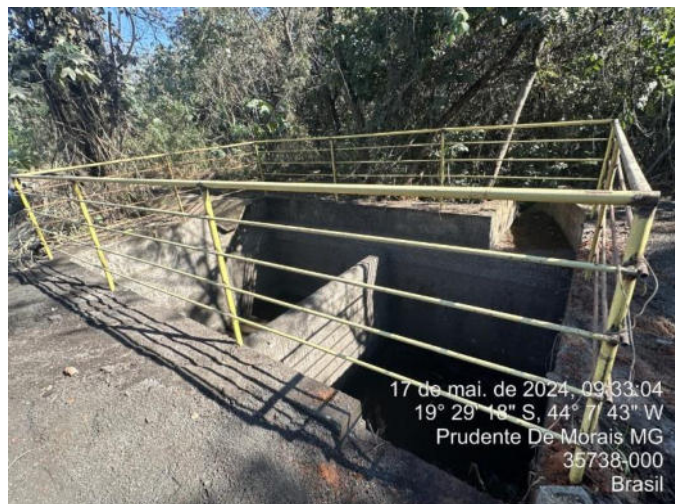
Foto 24: Caixa de decantação próxima ao galpão de triagem
