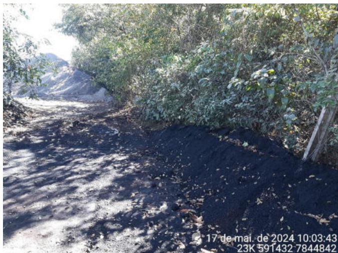
Foto 43: Material disposto na divisa da propriedade com escorregamento para fora da área.
