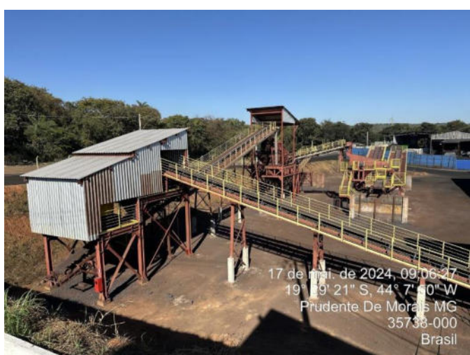
Foto 29: Área da sinterização com os enclausuramentos instalados
