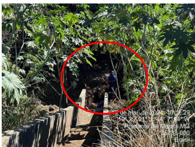
Foto 27: Implantação de uma terceira caixa de decantação, que irá incorporar o sistema de drenagem do empreendimento
