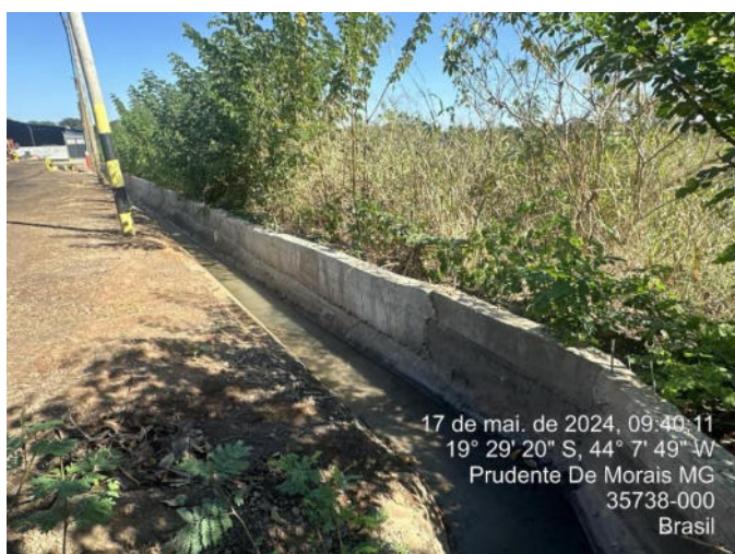
Foto 5: Canaleta de drenagem que precisou ser alteada
