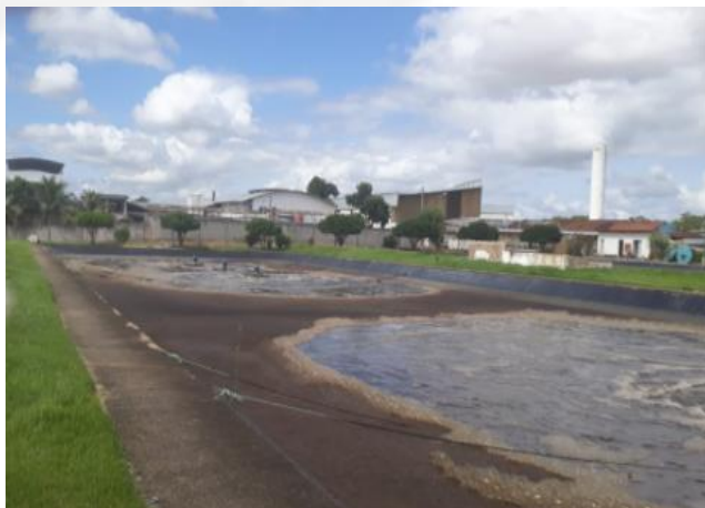
Foto 01. Lagoas para tratamento de efluentes líquidos industriais.
