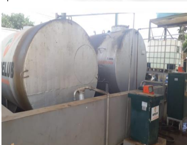
Foto 03. Ponto de Abastecimento.
