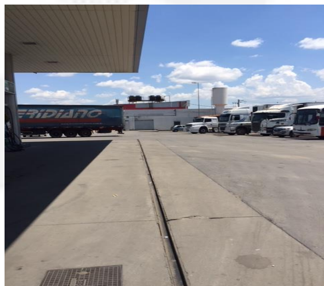
Foto 04. Canaletas da pista de abastecimento sob a projeção do teto
