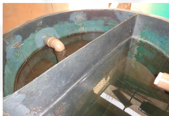
Foto 07. Suspiros dos tanques
