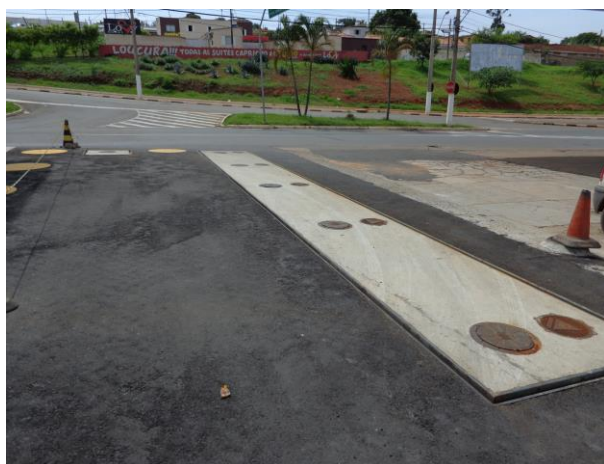
Foto 04. Bocas de descarga dos tanques
