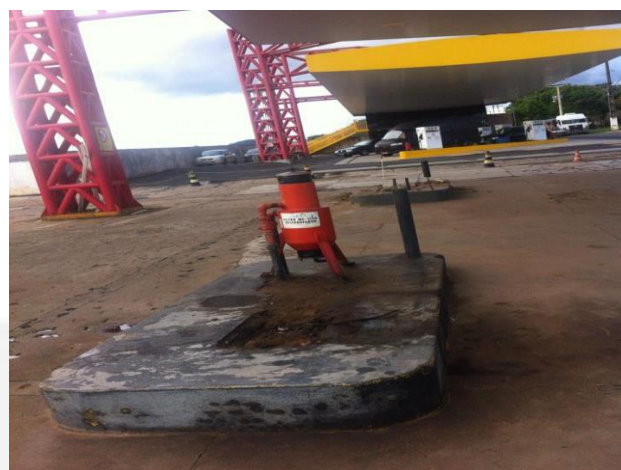
Foto 05. Bombas removidas da pista antiga
