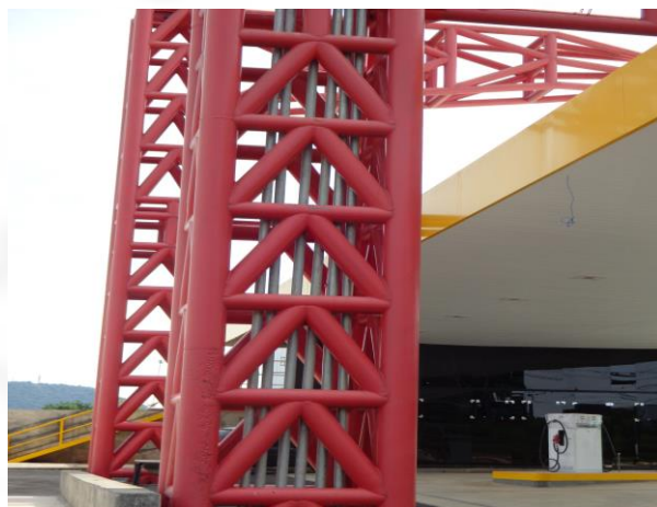
Foto 07. Suspiros dos tanques
