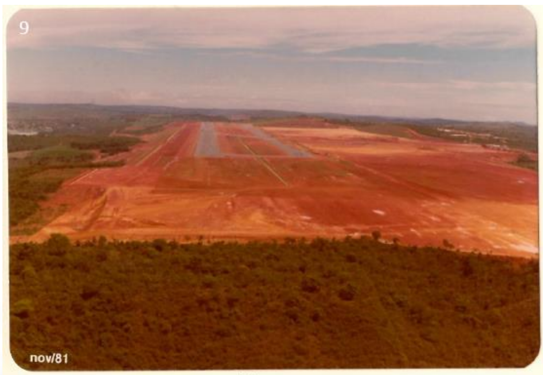
Foto 9: Vista de SE para NW - Áreas do pátio e do terminal ainda em processo de terraplanagem.
