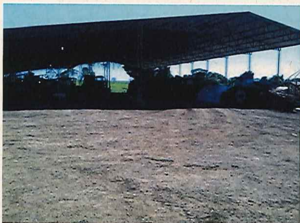
Figura 11. Barracão de máquinas e implementos agrícolas
