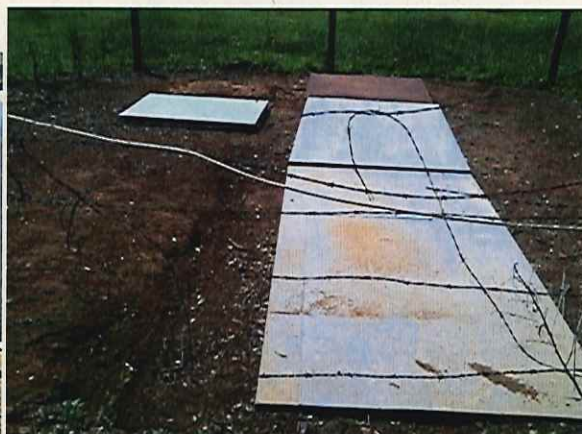
Figura 2. Caixa separadora de água e óleo - CSAO
