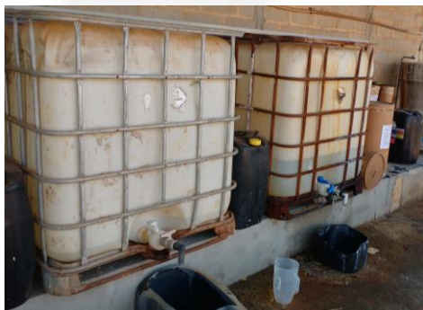
Foto 05. Galpão de armazenamento de produtos químicos coberto e com piso impermeabilizado.
