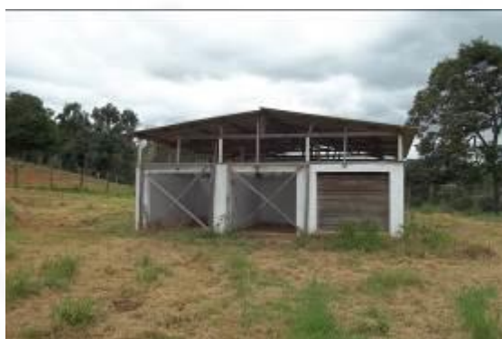
Foto 04. Galpão de compostagem.
