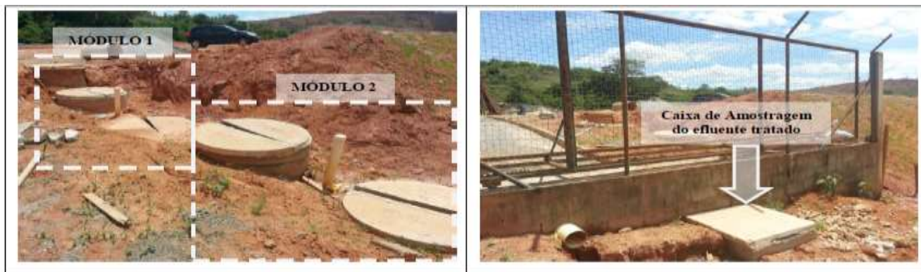
Figura 2 – Unidade de tratamento do efluente sanitário.
