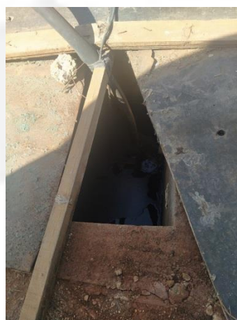
Foto 6: Caixa onde o efluente sanitário encontra o industrial
