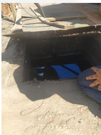
Foto 5: Caixa de gradeamento, sem proteção adequada na superfície, com recobrimento precário
