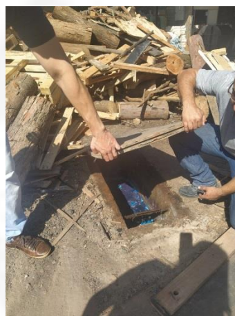
Foto 4: Grade com ponto de acesso obstruído pela lenha
