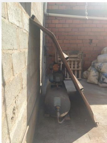
Foto 16: Compressor sem bacia de contenção
