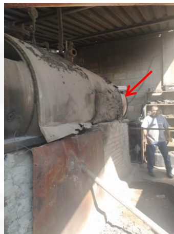
Foto 10: Caldeira com possível corrosão
