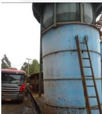
Foto 05. Estruturas e vias existentes na
