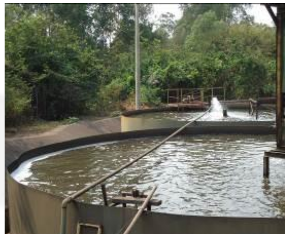
Foto 08. Estruturas existentes na APP.
