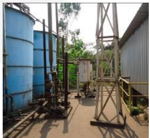
Foto 06. Estruturas existentes na APP.
