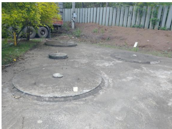
Foto 5 - Sistema Fossa/filtro/sumidouro
