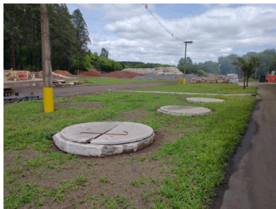
Foto 6 - Sistema Fossa/filtro/sumidouro
