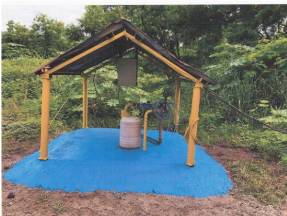
Foto 3 - Poço de captação 1 (adequação) Foto 4 - Poço de captação 2
