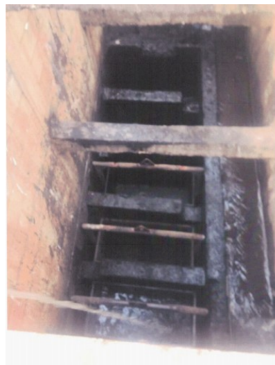
Foto 8 - Caixa retenção sólidos (limpeza)
