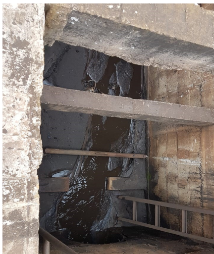
Foto 7 - Caixa retenção sólidos (vistoria)
