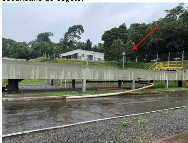
Foto 04: Queimador de gases.
