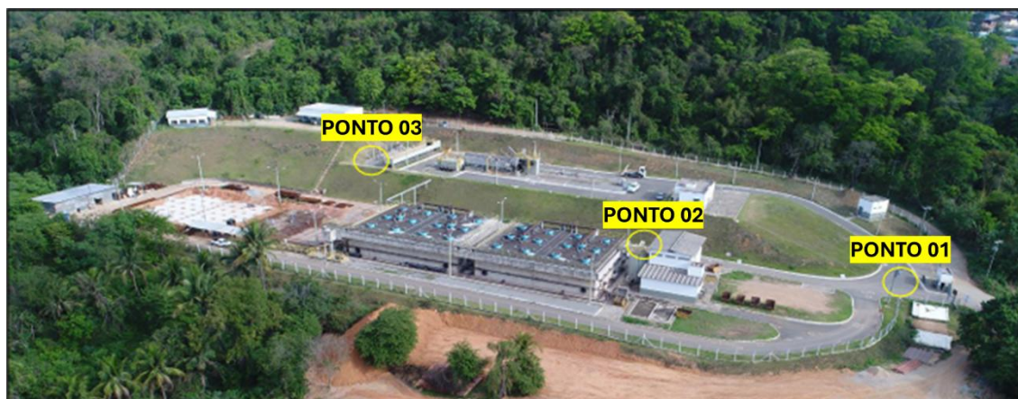
Figura 5. Vista da ETE Limoeiro indicando os pontos de medição de ruídos. Fonte: Adaptado de Relatório Técnico COPASA, SEI 98743093.
