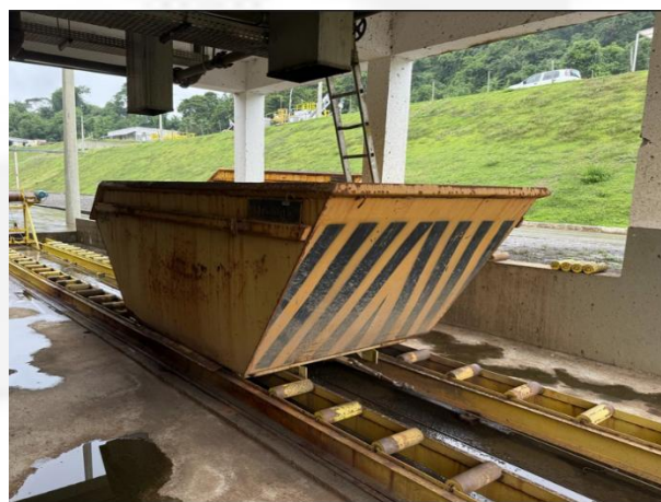
Foto 06: Lodo desidratado armazenado na caçamba até ser destinado ao aterro sanitário.
