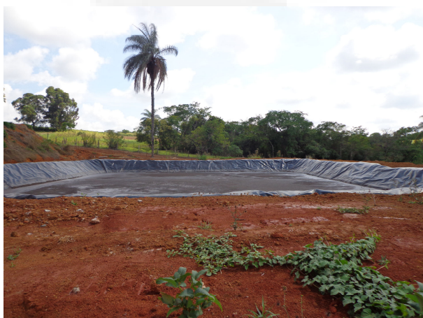
Foto 03. Lagoa de estabilização.
