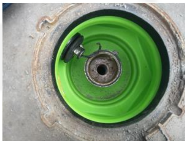
Foto 04. Instalação do Sistema de Monit. Intersticial
