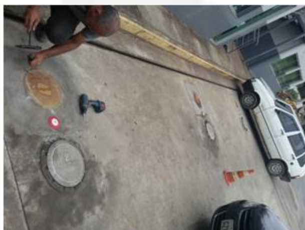
Foto 03. Instalação do Sistema de Monit. Intersticial
