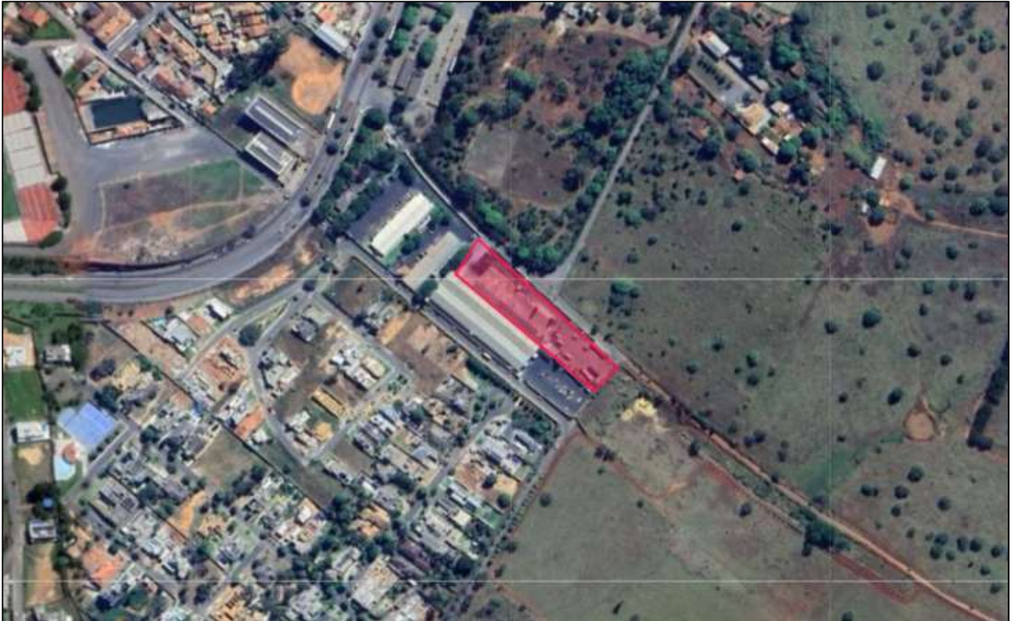
Figura 1: Vista do empreendimento (Fonte: SLA).
