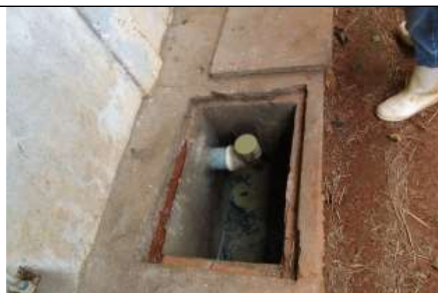
FOTO 2 - Vista da tubulação / caixa de passagem do efluente instalados no galpão de engorda.
