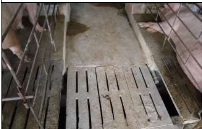
FOTO 3 – Vista do piso vazado com canaleta de coleta de efluente no galpão da gestação.
