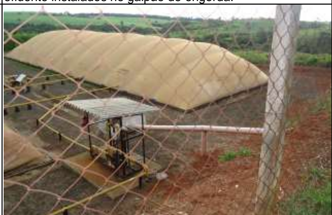
FOTO 4 – Vista parcial dos biodigestores e tubulação de saída do gás.
