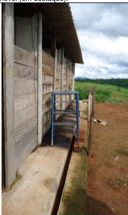
FOTO 5 – Sistema de compostagem com canaleta para coleta do chorume.
